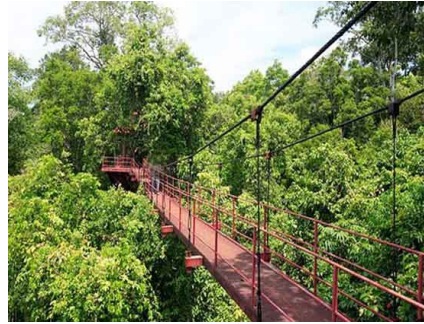
สะพานเรือนยอดไม้สวนพฤกษศาสตร์ทุ่งค่าย จังหวัดตรัง
